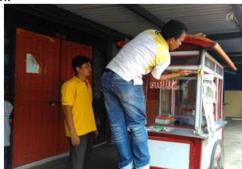
Gambar 6: Pemasangan pembangkit surya
